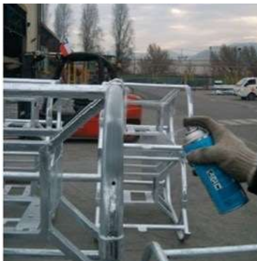
Reparación con pintura de zinc
