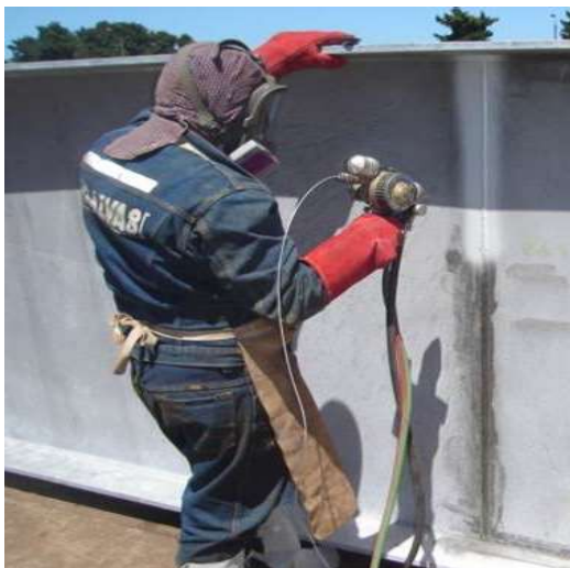
Reparación con Zinc en aerosol (Metalizante)
