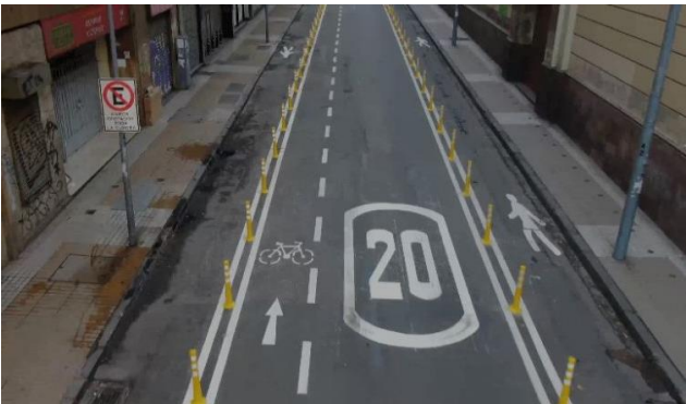
SANTIAGO: Ampliar veredas y vía segregada para ciclos
